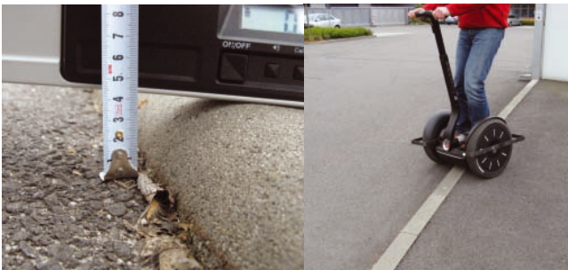
Abbildung 2: Unproblematisches Befahren abgesenkter Borde
