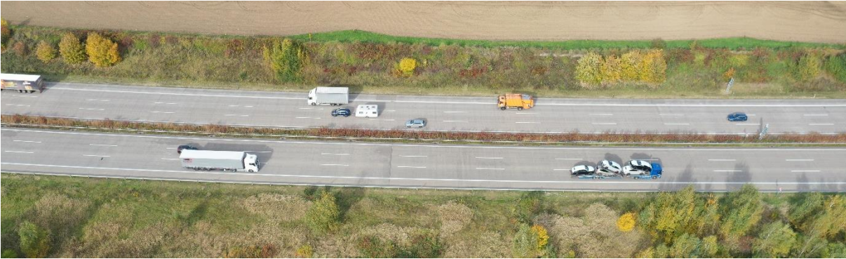
Abbildung 10: Aufnahme der A 4 zwischen der AS Chemnitz-Ost und der AS Frankenberg
