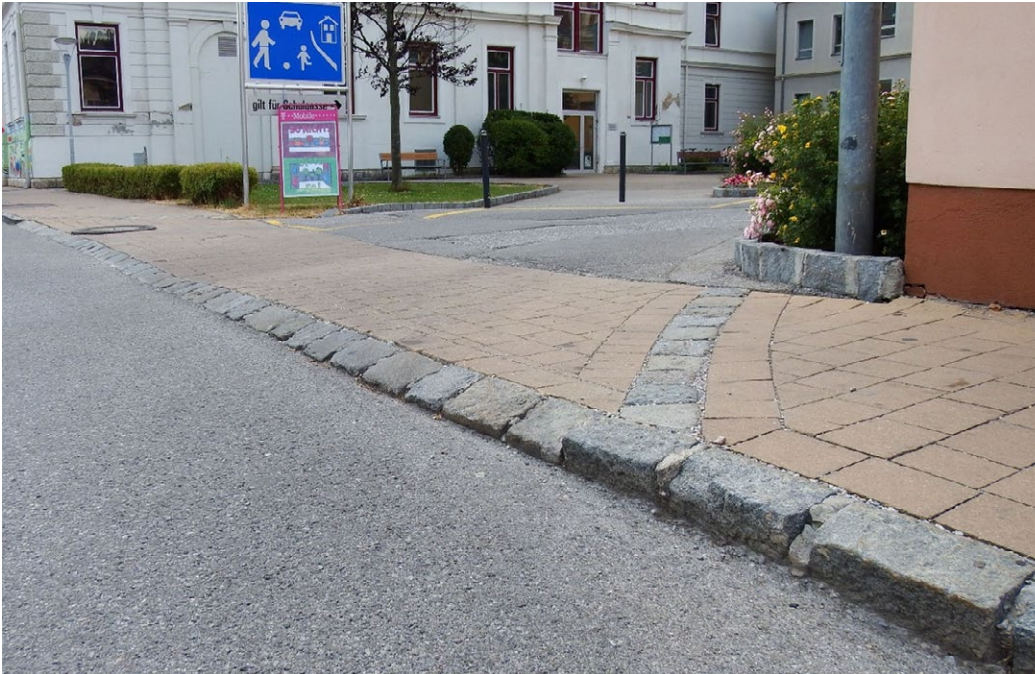
Abbildung 6: Problematische Gestaltung der Einfahrt in eine Wohnstraße mit deutlicher Höhendifferenz, steilem Bordsteinwinkel und teilweiser Kante (Österreich)
