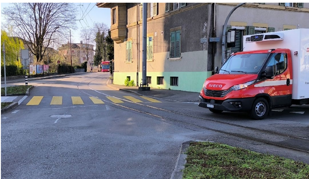
Abbildung 10: Spitzwinklige Gleisquerung (Schweiz)
