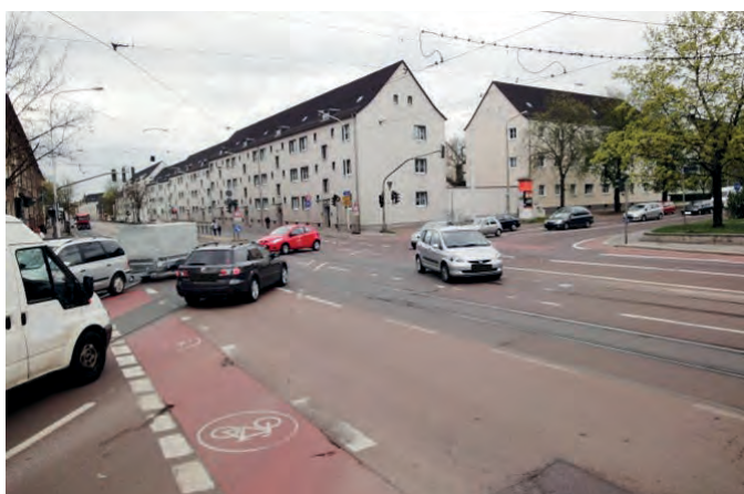
Fehlende und abgefahrene Markierung einer LSA-Kreuzung ohne Linksabbiegerschutz und dazugehöriges Unfalldiagramm
