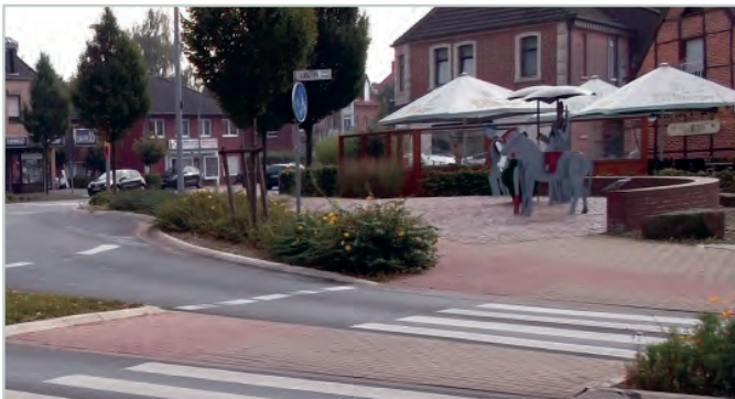
Schlecht sichtbarer und abgesetzter Radweg
